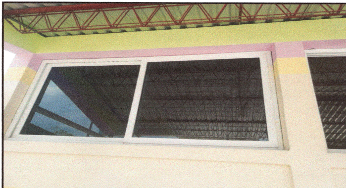
FOTO 3: SE REALIZO REPARACION EN VENTANAS.
