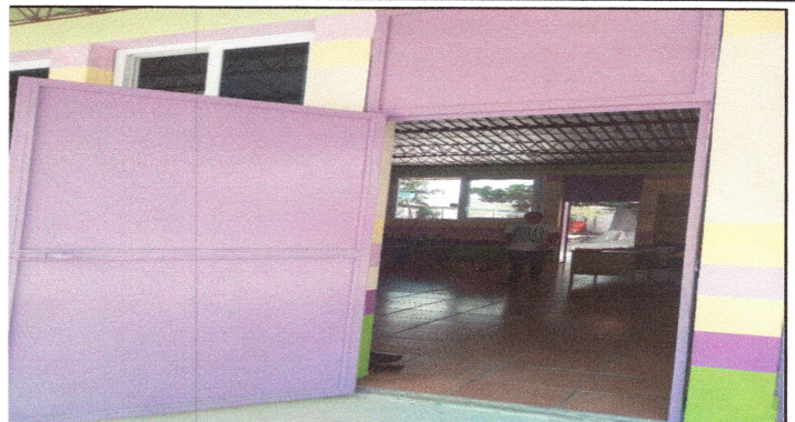
FOTO 2: SE REALIZO EL REMOSAMIENTO EN PUERTAS.
