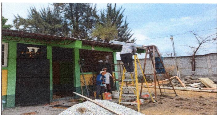
FOTO 7: REALIZANDO EL CAMBIO DE CANALES Y BAJADAS DE AGUA PLUVIAL.
