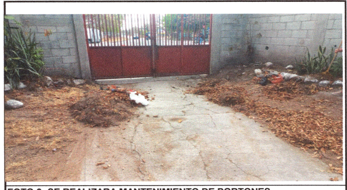
FOTO 8: SE REALIZARA MANTENIMIENTO DE PORTONES.
