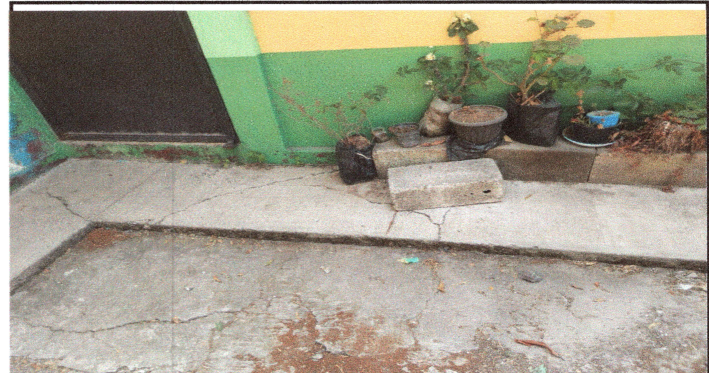
Foto 10: REMOSAMIENTO DE LOSA DE PATIO.
