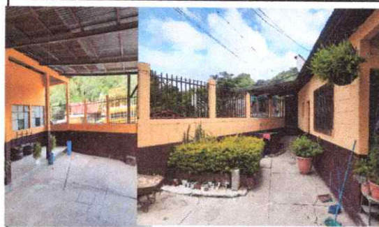
Foto 2: CERCO O MURO PERIMETRAL
