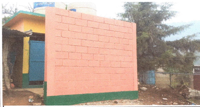
foto 5: Restauración de muro de pared en área de sanitarios.
