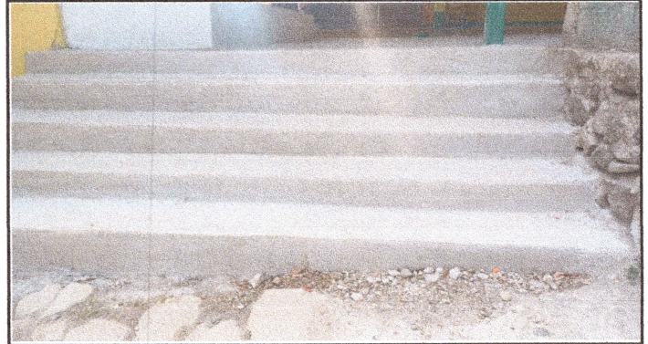
Foto 2: restauración de losa de cemento en gradas de ingreso de escuela.
