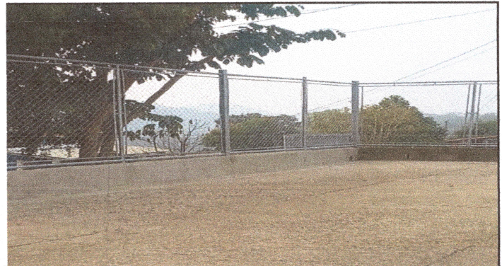
foto 4: Restauración de malla perimetral en cancha deportiva.
