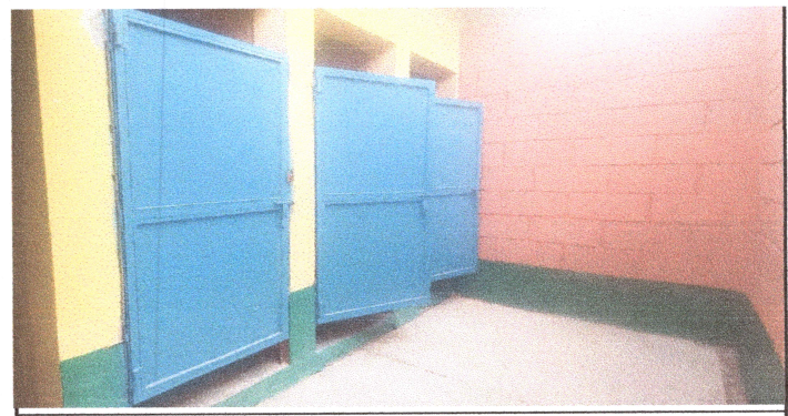
foto 6: reposicion de puertas en sanitarios.
