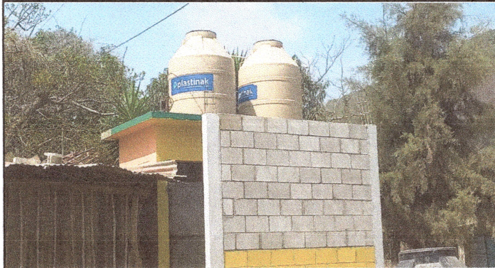
foto 1: Reposición de depósitos de agua para los sanitarios.
