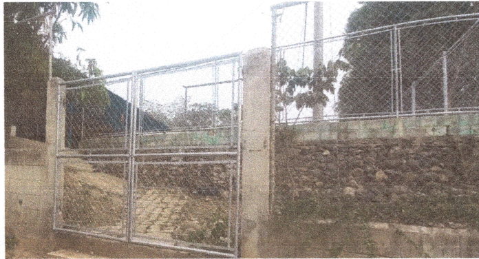
foto 3: reposicion de portón de acceso a escuela.
