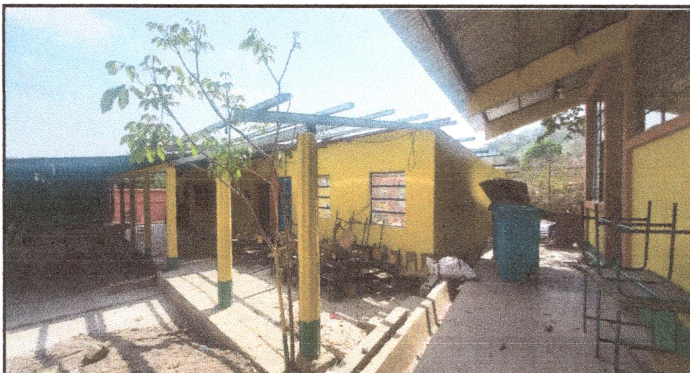
foto 1: Cambio de cubierta de lámina en aula.
