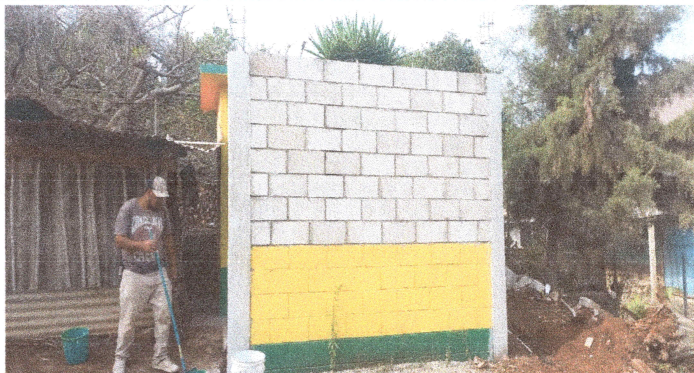
Foto 2: Restauración de muro de pared en área de sanitarios.
