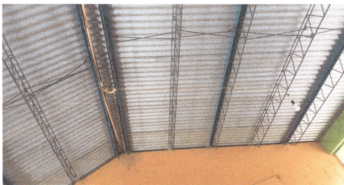
foto 5: previo a la instalacion de la nueva red electrica.
