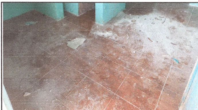
foto 3: Instalación de piso cerámico en área de cocina
