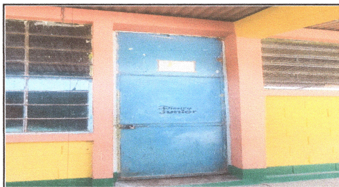
foto 4: Pintura de puertas de la escuela.
