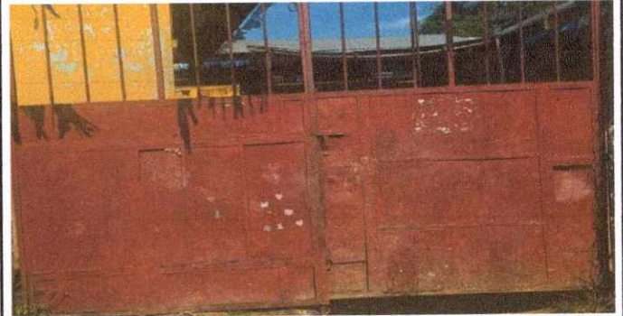
Foto 2: SUSTITUCIÓN DE PORTON DE TUBO CON MALLA
