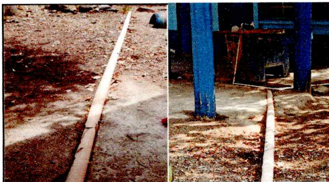
Foto4: REPARACION DE RED DE DRENAJES Y AGUA POTABLE
