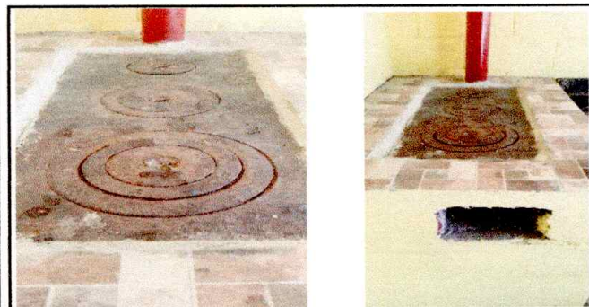
Foto: REPARACION O SUSTITUCION DE AREA DE COCINA
