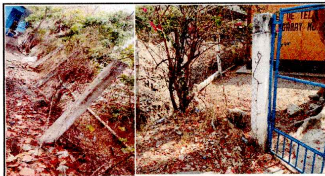
Foto3: CERCO O MURO PERIMETRAL
