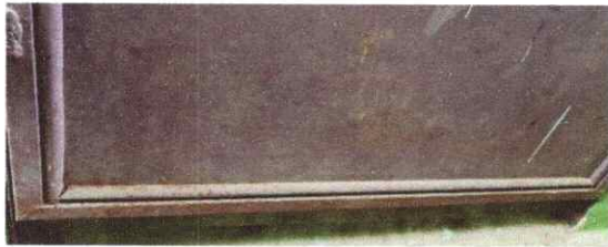
Foto1: REPARACION DE PUERTAS
