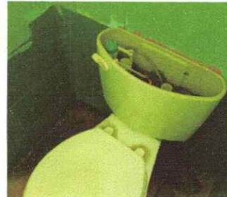
Foto 4: SUSTITUCION DE SERVICIOS SANITARIOS
