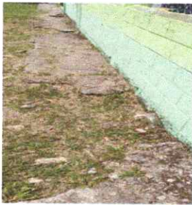
Foto 9: SUSTITUCION DE LOSA DE PATIO
