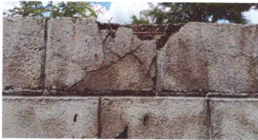
Foto 7: SUSTITUCION DE MURO PERIMETRAL
