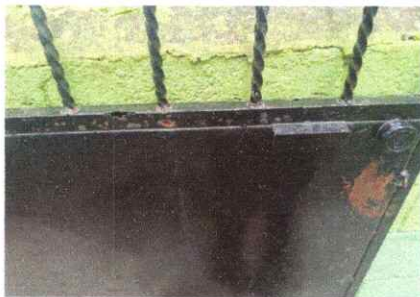
Foto 5: SUSTITUCION DE PORTON DE INGRESO
