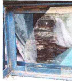
Foto 2: SUSTITUCION DE VENTANAS
