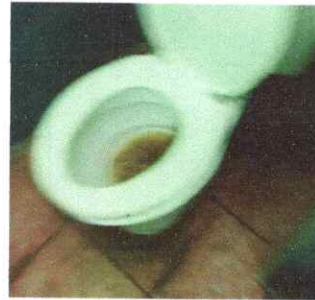
Foto 8: SUSTITUCION DE DRENAGES DE AGUAS NEGRAS Y AGUA POTABLE
