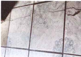
Foto 3: SUSTITUCION DE PISO CERAMICO
