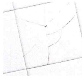
Foto 6: SUSTITUCION DE AZULEJO
