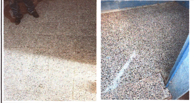
FOTO 2: Cambio de piso.
