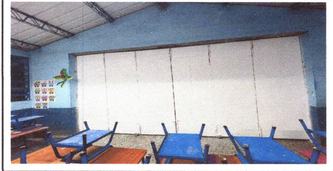
Foto: Reparación de puertas (contrachapado)
