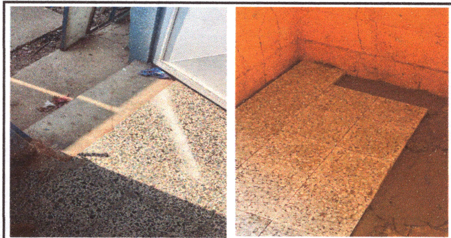
FOTO 2: Cambio de piso.
