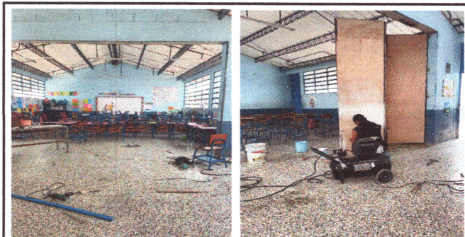
Foto: Reparación de puertas.
