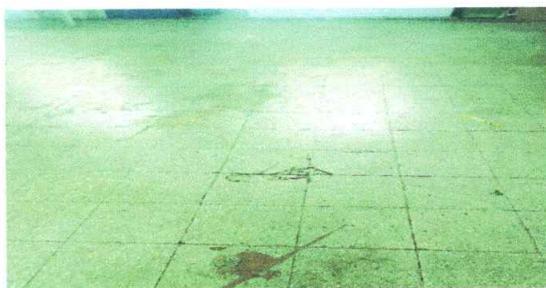
Foto 6: Piso Granito (sustitución)
