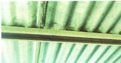
Foto 2: estructura de techo ( cambio de costanera)
