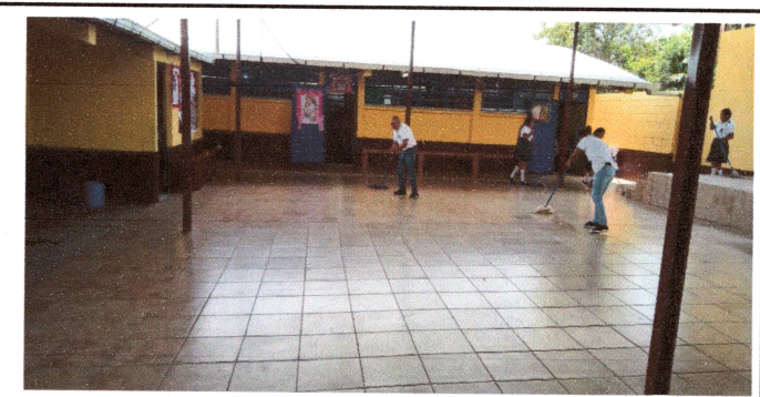
Foto: 6 TERMINADO CAMBIO DE CANAL DAÑADO
