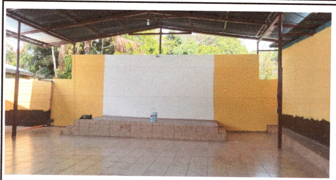
FOTO 2: TRABAJO TERMINADO DE LA LOSA MAS COLOCACION DE PISO
