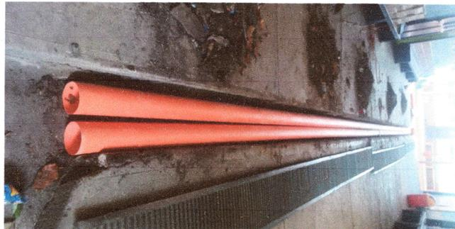
Foto 5 TRABAJANDO EL CAMBIO DE DRENAJE Y RECUBRIMIENTO DE LOSA A TUBERIA EXPUESTA
