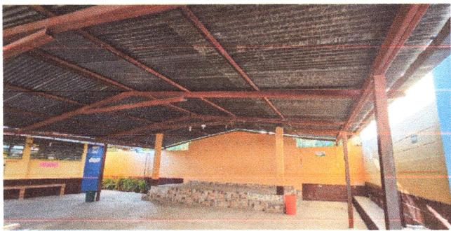
Foto1: SE REALIZARA EL LEVANTADO DE LA CUBIERTA DE TECHO MAS PINTURA
