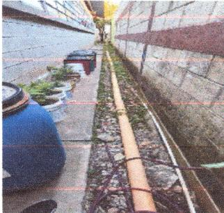
Foto 5 SE REALIZARA EL CAMBIO DE DRENAJE Y RECUBRIMIENTO DE LOSA A TUBERIA EXPUESTA
