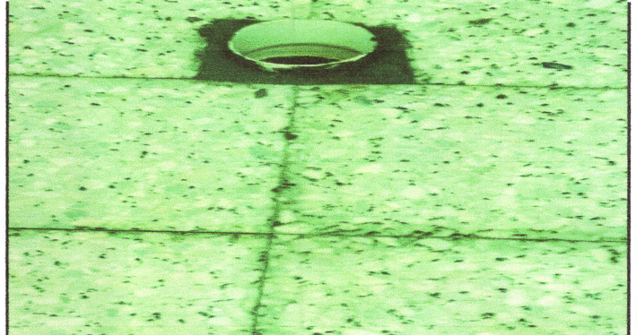
Foto4: SANITARIOS Y DRENAJES Y TUBERIA DE AGUA DE 3 MODULOS. VIVIENDAS DE ESTUDIANTES.
