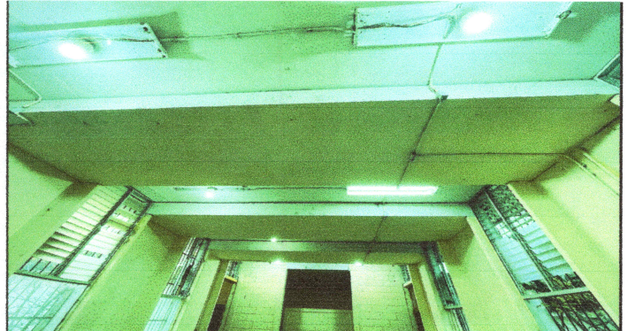
FOTO 2: REMOZAMIENTO DE RED ELECTRICA DE LA COCINA.
