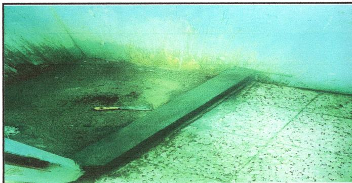
Foto: 5 Duchas y sistema de drenaje colapsados
