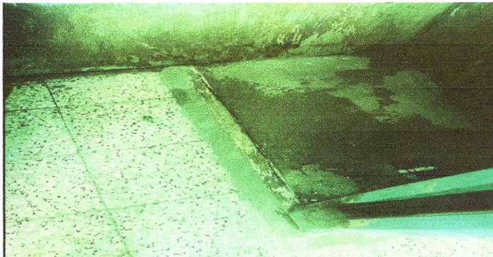
Foto: 6 Duchas y sistema de drenaje colapsados
