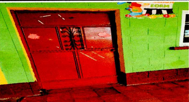
Foto 5: Puertas con pintura y chapa en mal estado
