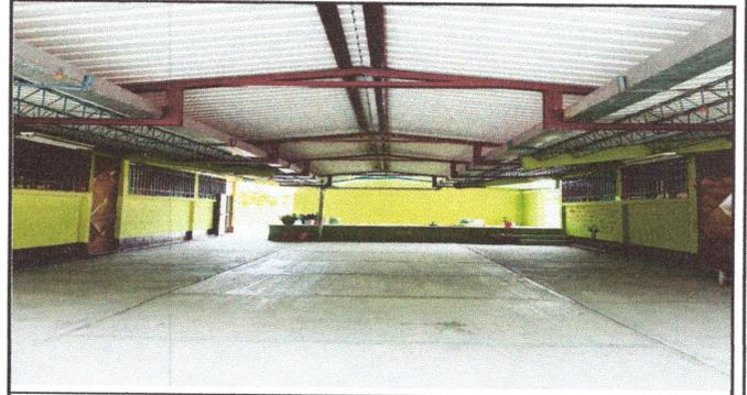
FOTO 2: Cambio de cubierta finalizado.
