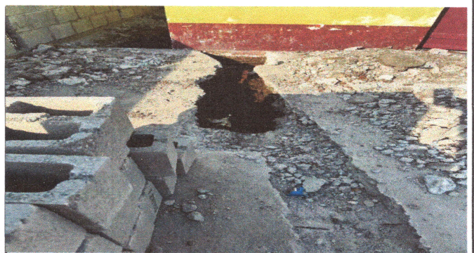
Foto 6: reparación de drenaje y red de agua potable.
