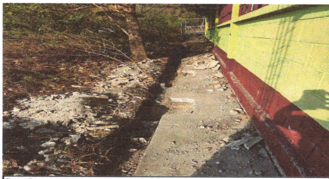
Foto 5: preparativos para el cambio del muro.
