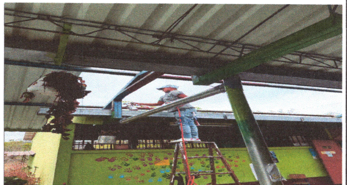
Foto 4: pintura de estructura para colocar la nueva cubierta.
