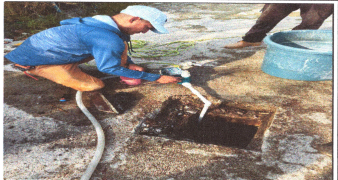
FOTO 2: Se puede observar el inicio de mantenimiento de la cisterna de la escuela.
