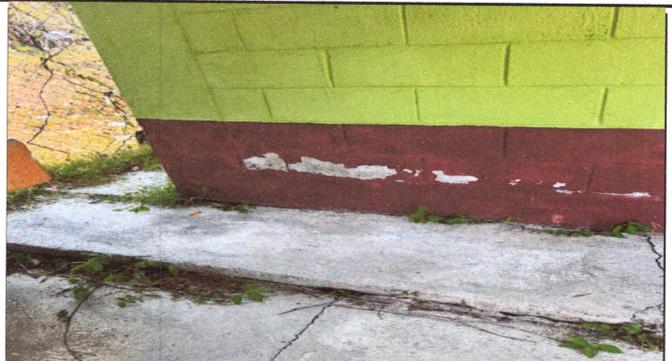
FOTO 8: Estado actual de la pintura de paredes exteriores.
