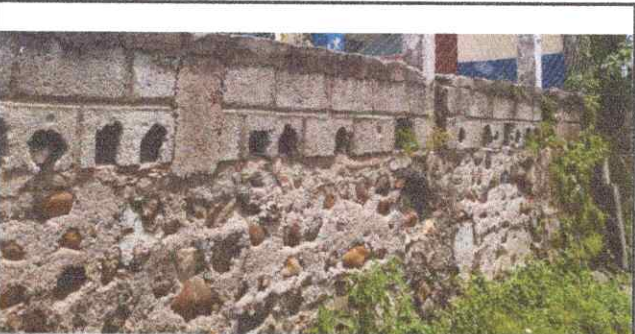
FOTO 8.1. SUSTITUCION MURO DE CONCRETO CICLOPEO.
