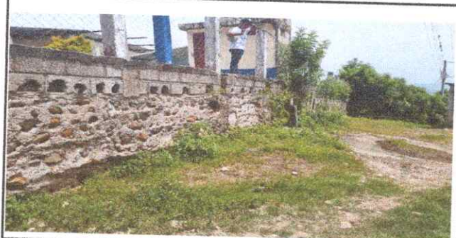
FOTO 4.1. SUSTITUCION DE CERCO PERIMETRAL CON BLOCK Y MALLA.
