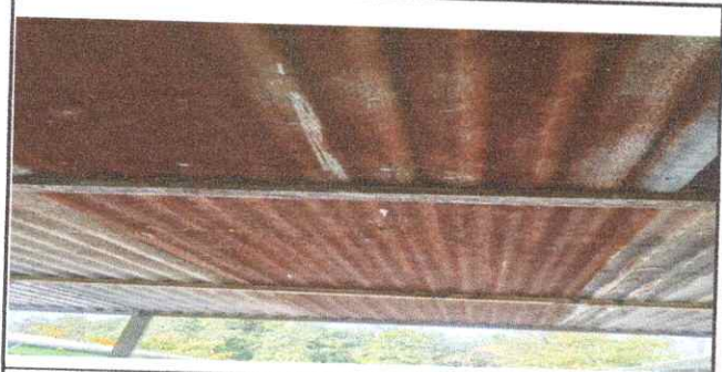
FOTO 2.1. SUSTITUCION ESTRUCTURA DE TECHO.
