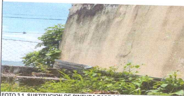
FOTO 3.1. SUSTITUCION DE PINTURA BASE AGUA.
