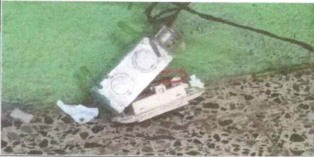
FOTO 5.2. SUSTITUCION DE TOMACORRIENTE.
