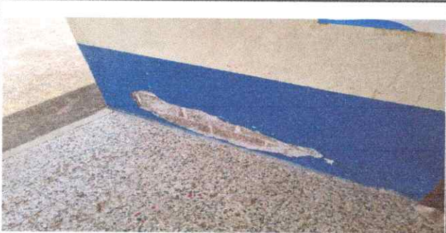
FOTO 6.1. SUSTITUCION DE REPELLO Y CERNIDO.
