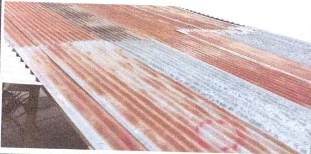
FOTO 1.1. SE SUSTITUCION LAMINA TROQUELADA.
