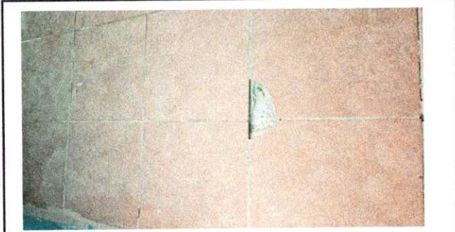
Foto1: SUSTITUCIÓN PISO CERÁMICO
