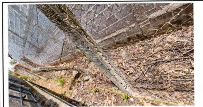
Foto 3: SUSTITUCIÓN DE CERCO PERIMETRAL CON BLOCK Y MALLA
