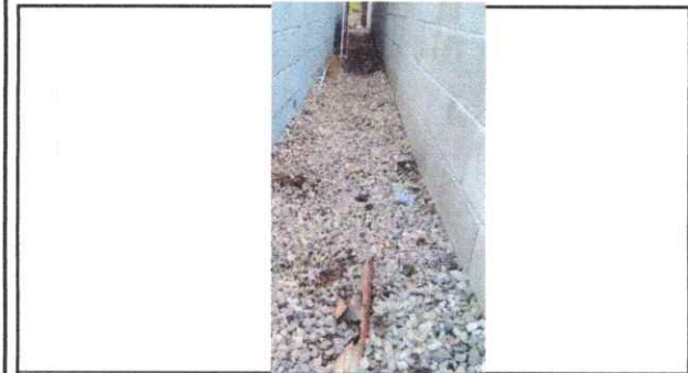
Foto 3: REPARACION DE RED DE DRENAJES
