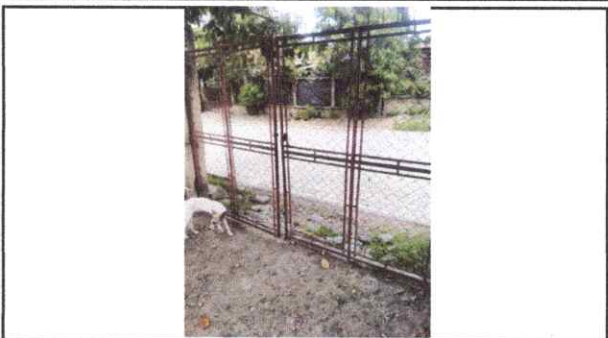
Foto 2: MANTENIMIENTO DE PORTONES
