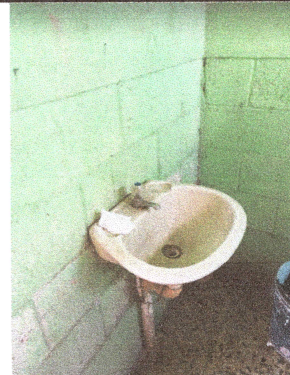
Foto4: desinstalar lava manos, reparar drenajes y colocar nuevo lava manos
