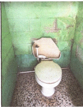
Foto: 5 desinstalar 3 sanitarios, reparar modulo, reparar drenajes e instalar sanitarios nuevos. (lado de niñas)
