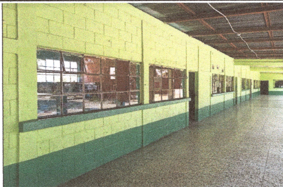
Foto3: Levantar cubierta de lamina, pintar lamina, pintar estructura y colocar nuevamente la cubierta de lamina a 698 mts2.
