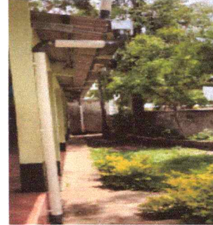
Foto 2: CANAL Y BAJADAS PLUVIALES INSTALADAS
