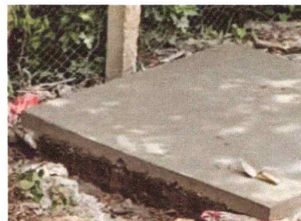
Foto 6: LOSA DE PATIO TERMINADA
