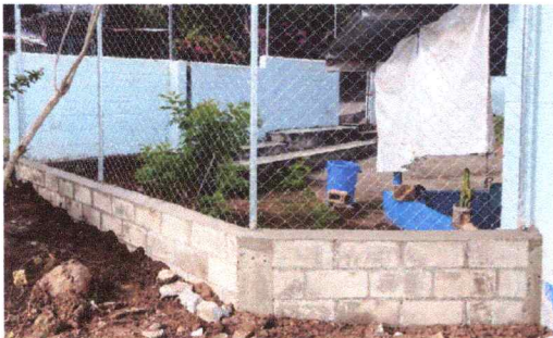
Foto 5: MURO PERIMETRAL FINALIZADO
