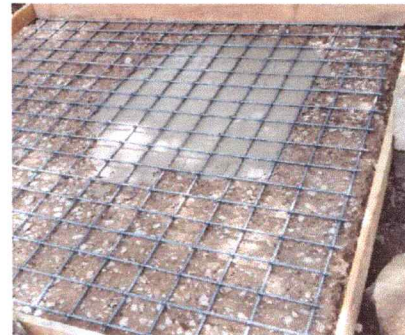
FOTO 6: REPARACION DE LOSA DE PATIO
