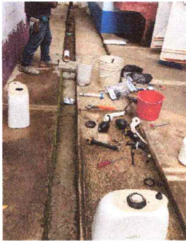
Foto 3: SUSTITUCION DE MURO PRERIMETRAL
