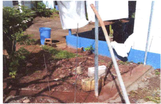
Foto 4: SUSTITUCION DE MURO PERIMETRAL
