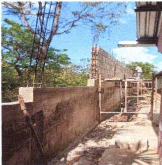
FOTO 5: REPARACION DE MURO PERIMETRAL
