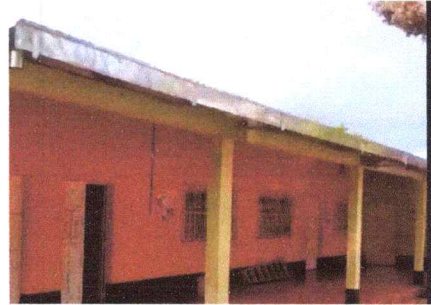
Foto 2: INSTALACION DE CANALES PLUVIALES
