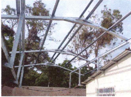
Foto1: PROCESO DE SUSTITUCION DE ESTRUCTURA METALICA
