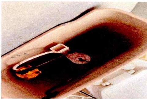
Foto 3: SISTEMA INTERNO DE SERVICIOS SANITARIOS INSERVIBLE
