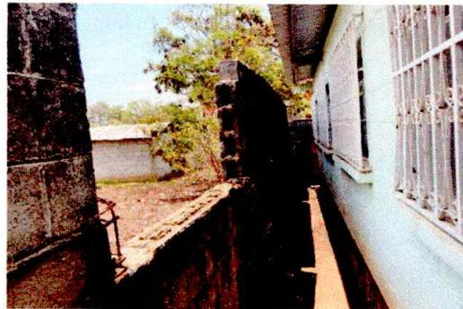
Foto 4: SE APRECIA EL MURO PERIMETRAL DERRUMBADO (SUSTITUCION MURO DE BLOCK)
