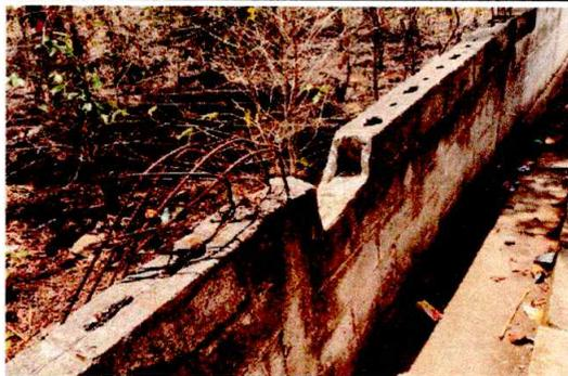
Foto 5: SUSTITUCION DE MURO PERIMETRAL
