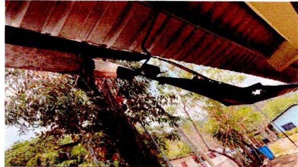
Foto 2: SUSTITUCION DE CANALES DE AGUA PLUVIAL
