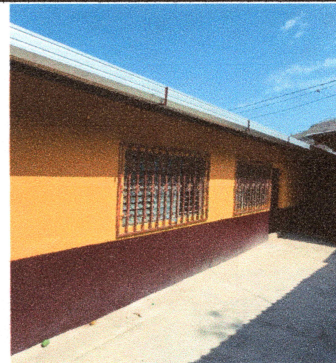
Foto 2: Se cambió el Canal de Agua.
