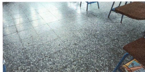
Foto 6: cambio de piso aula
