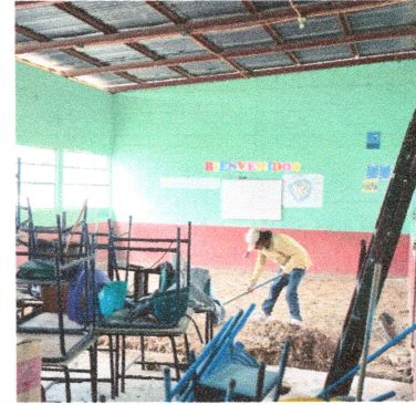
Foto 4: Se cambió piso por encontrarse en mal estado.
