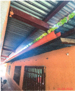
Foto3: fabricar e instalar canal de 35 mts. De largo
