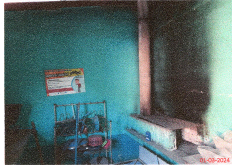
Foto4: derribar pared intermedia de cocina, derribar plancha antigua, elaborar e instalar plancha nueva.
