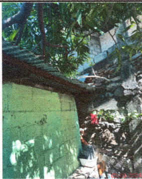
Foto: 5 levantar pared de cocina, reparar estructura, reparar techo, pintar estructura, pintar techo, levantar la sombra de arbol frutal para que no tope en el techo
