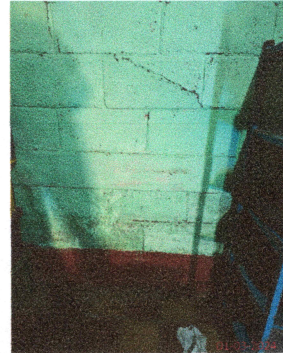
FOTO 2: reparación de muros dañados y de suelo undido en aula
