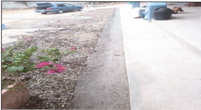
FOTO 8: SE REALIZO REPARACION DE CUNETA DE CONCRETO
