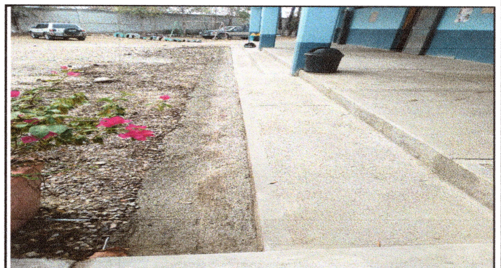
FOTO 9: SE REALIZO REPARACION DE CUNETA DE CONCRETO.
