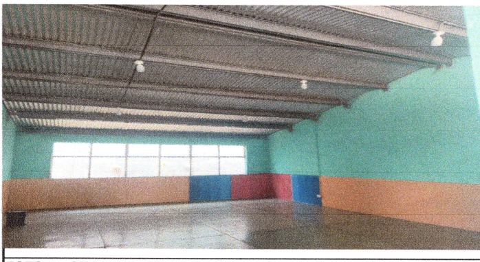
FOTO 11: SE REALIZO PINTURA EN MUROS INTERIOR Y EXTERIOR.
