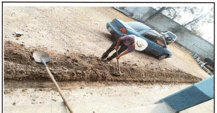
FOTO 10: REALIZANDO LA REPARACION DE LA CUNETA DE CONCRETO.
