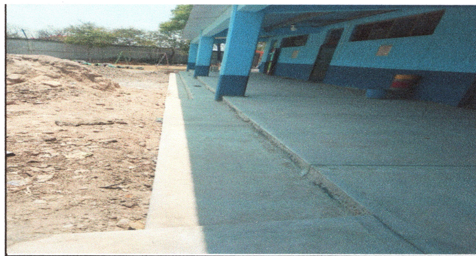
Foto 11: SE REALIZARA REPARACION DE CUNETA DE ACCESO A LA INSTITUCION EDUCATIVA.
