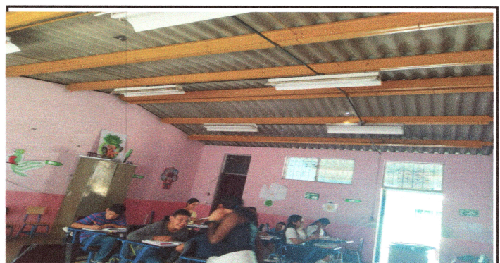
Foto 12: SE REALIZARA PINTURA EN MUROS INTERIORES.
