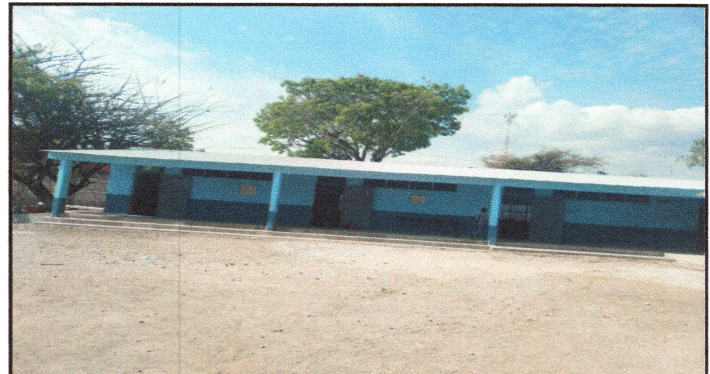
Foto 10: SE REALIZARA REPARACION DE CUNETADE ACCESO A LA INSTITUCION EDUCATIVA.
