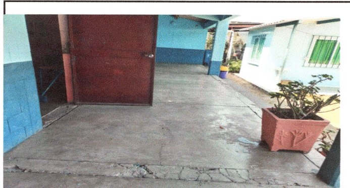
Foto 9: SE REALIZARA REPARACION DE PUERTAS.
