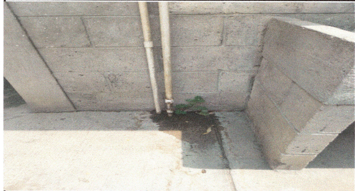
Foto 7: SE REALIZARA REPARACION DE CISTERNA/ DEPOSITO DE AGUA.
