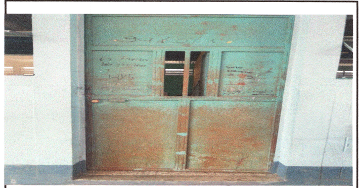
Foto 8: SE REALIZARA REPARACION DE PUERTAS.
