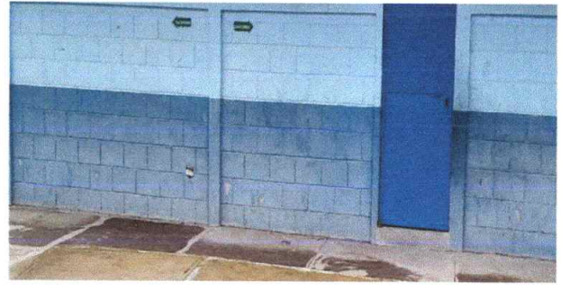
Foto 2: PINTURA (MODULOS EXTERIORES)
