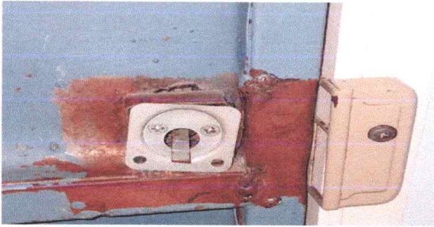
Foto 1: PUERTAS (CAMBIO DE CHAPAS, PINTURA, MANTENIMIENTO DE BASE)
