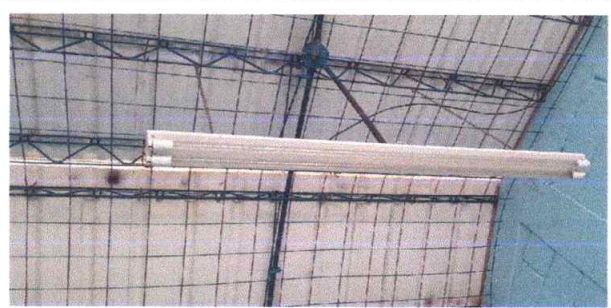
Foto 6: REPARACIÓN DEL SISTEMA ELÉCTRICO (SUSTITUCIÓN)
