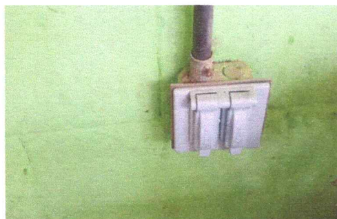
Foto 3: MANTENIMIENTO AL SISTEMA ELECTRICO.
