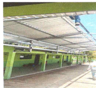
Foto 6: SUSTITUTO DE CANALES Y BAJADAS DE AGUA.
