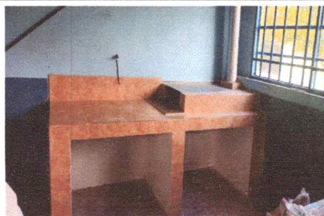
Foto 4: SUSTITUCION DE ESTUFA RURAL
