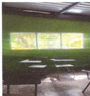
Foto 2: SUSTITUCION DE VENTANA.
