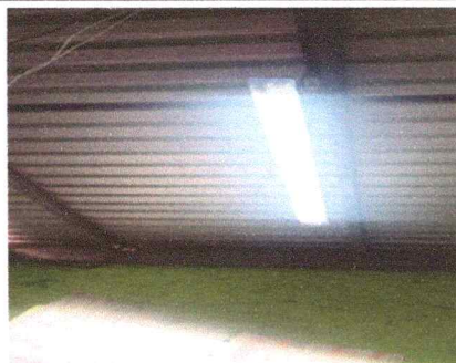
Foto 5: SUSTITUCION DE LAMPARAS.
