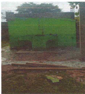
Foto 5: Sustitucion de techo
