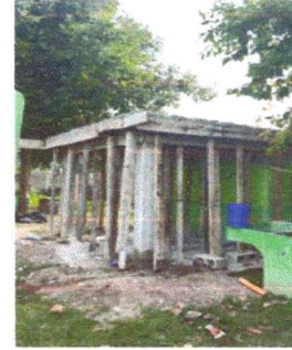
Foto 2: SUSTITUCION DE TECHO DE BAÑOS
