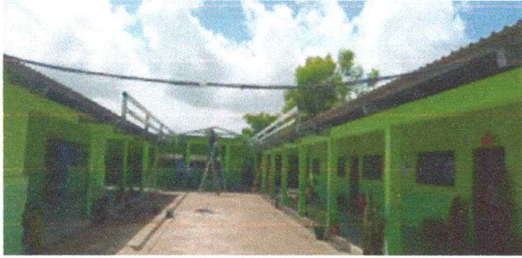
Foto1: SUSTITUCION DE LAMINA POR TROQUELADA A DOS AGUAS MAS CAPOTE
