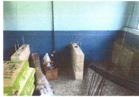
Foto 4: Sustitución de área de cocina
