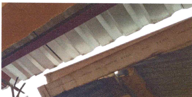
Foto 3: SE SUSTITUIRA EL CANAL MAS BAJADAS.
