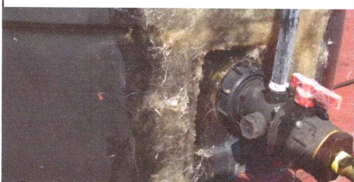
Foto 4: SUSTITUCION DE TINACO DE AGUA CON OPERACIÓN POR GRAVEDAD.
