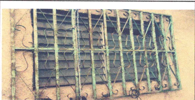
Foto 5: MANTENIMIENTO DE MARCO PARA LA SUSTITUCION DE VENTANA POR INSTALACION DE UNA VENTANA.
