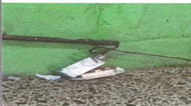
Foto 7: SE LE DARA MANTENIMIENTO AL SISTEMA ELECTRICO
