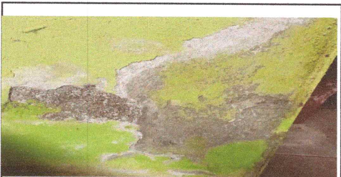
Foto 6: SE SUSTITUIRA REPELLO + CERNIDO.
