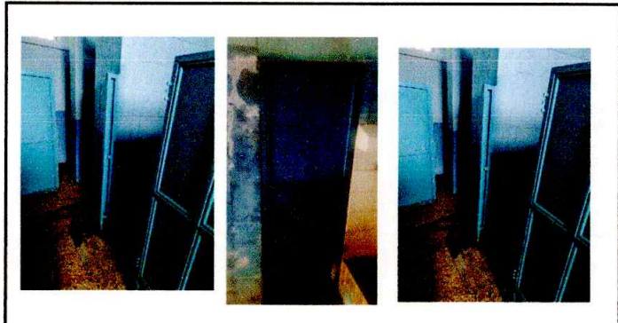
FOTO 2: Reposición de puertas de sanitarios.
