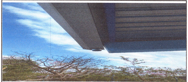
FOTO 2: COLOCACION DE BAJADAS DE AGUA Y SUS ACCESORIOS.
