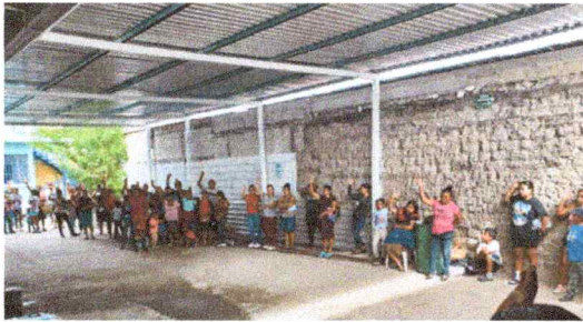
Foto 3: estructura de techo (mantenimiento estructura de techo)
