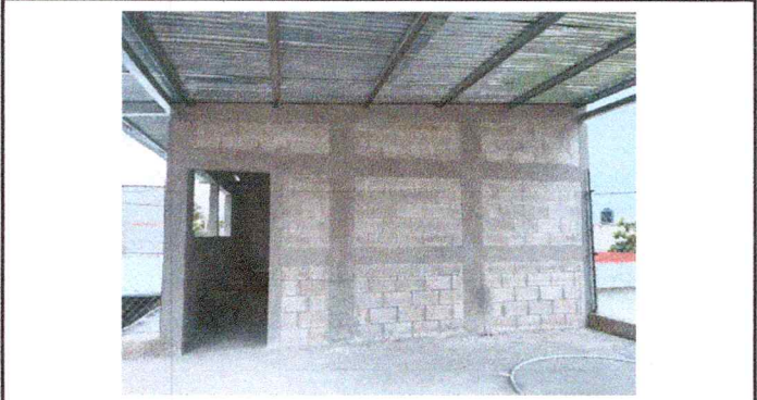
Foto 8: Reparación o sustitución de área de cocina (estufas rurales, pilas, ventanas, puertas, chimeneas, etc.)
