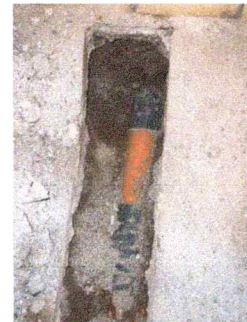
Foto 6: reparacion de red de drenajes y red de agua potable
