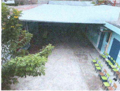
Foto 1: Cubierta de Lamina (sustitución de lamina por troquelada calibre 26 y mantenimiento)
