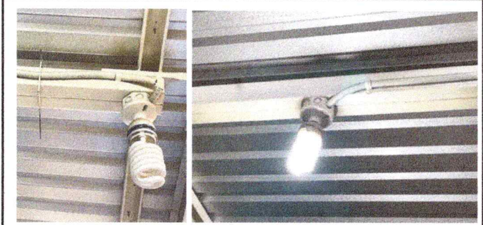
Foto 7: reparación de sistema electrico (reparacion)
