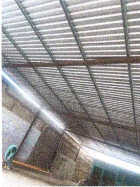
Foto1: Cubierta de Lamina (sustitución de lamina por troquelada calibre 26 y mantenimiento )
