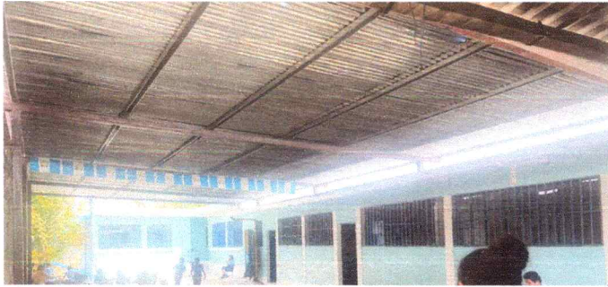
Foto1: Cubierta de Lamina (sustitución de lamina por troquelada calibre 26 y mantenimiento)
