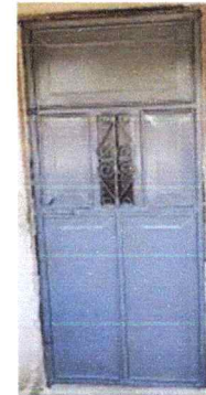
Foto 4: puertas (sustitucion puerta de aula)
