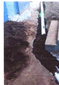
Foto 6:reparacion de red de drenajes y red de agua potable
