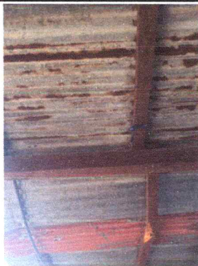
Foto 3: estructura de techo ( mantenimiento estructura de techo)
