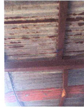
Foto 2: cubierta de lamina ( desmontaje, mantenimiento e instalac lamina existente)
