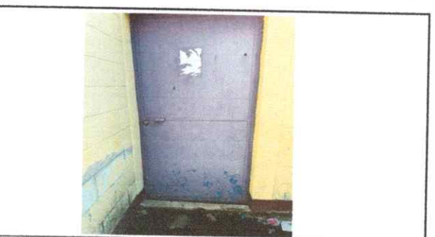
Foto 5: Sustitución de puertas y Mantenimiento.
