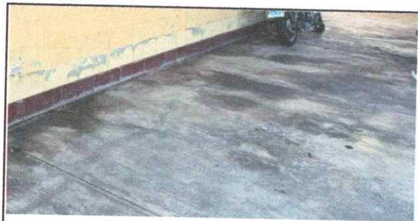
Foto 4: Cambio de losa de patio en mal estado.
