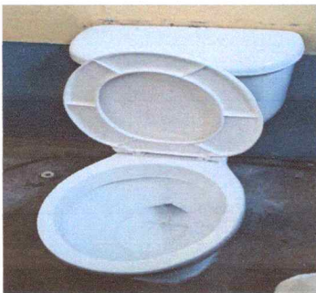
Foto 3: SANITARIOS SUSTITUCION COMPLETA DE 3 SANITARIOS.
