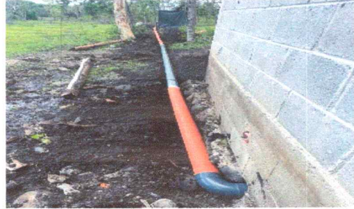
Foto 2: DRENAJE SUSTITUCION COMPLETA.
