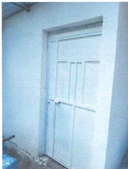
Foto 5: REPARACION DE AREA DE COCINA
