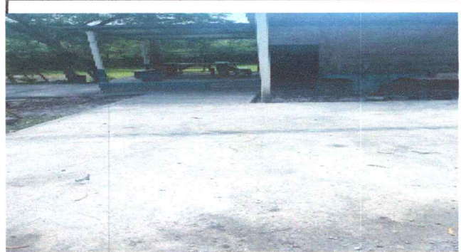
Foto 4: LA LOSA SE PATIO SUSTITUCION DE 48 M2.
