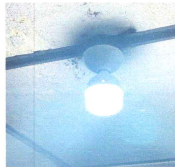
Foto 6: REPARACION DE SISTEMA ELECTRICO
