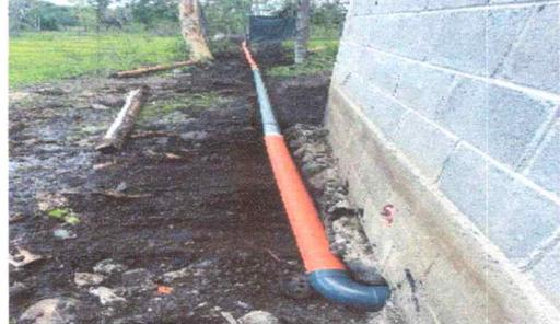
Foto 2: DRENAJE SUSTITUCION COMPLETA.
