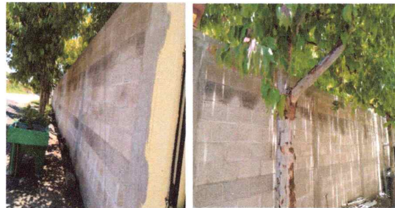
Foto 4: Cerco o muro perimetral (sustitución, muro de block)
