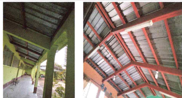
Foto: 6 Reparación de sistema eléctrico (sustitución)
