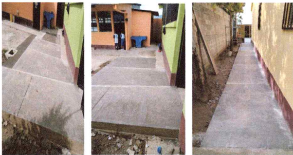
Foto: 5 Losa de patio (sustitución)
