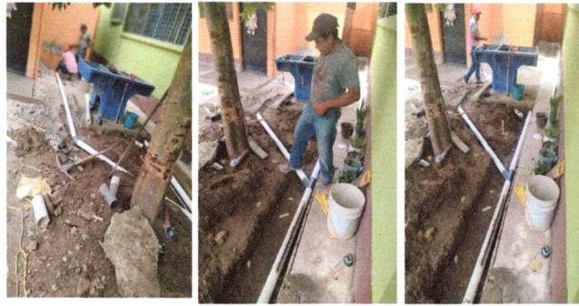
Foto3: Reparación de red de drenaje y red de agua potable (sustitución)
