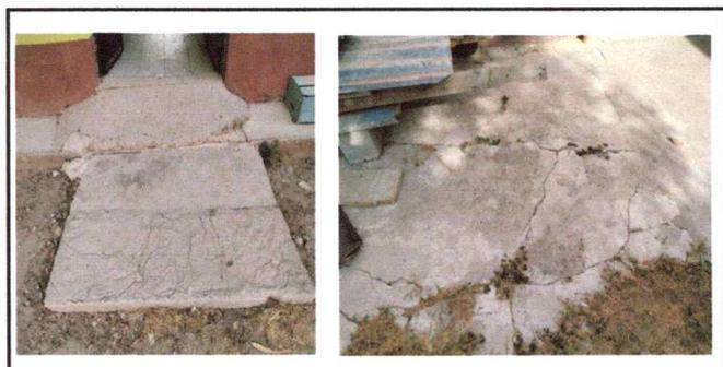
Foto: 5 Losa de patio (sustitución)
