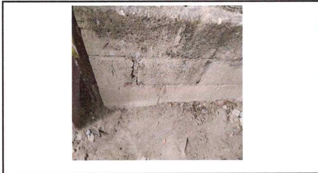
Foto 4: Cerco o muro perimetral (sustitución, muro de block)
