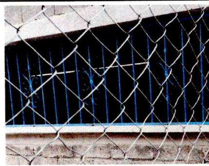
**Foto 6: ESPACIO DE VENTANA CUBIERTA CON MALLA GALVANIZADA**
