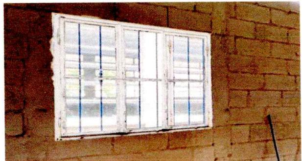
**Foto 5: LAS VENTANAS NECESITAN CAMBIO PARA EVITAR SE META EL AGUA, POLVO Y VIENTO**
